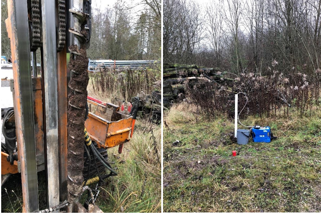
Figur 5. Till vänster: Jordprovtagning i punkt 22Ty25, 0-1 m u my. 2022-11-15. Till höger: Renspumpning av installerat grundvattenrör. 2022-11-16.
