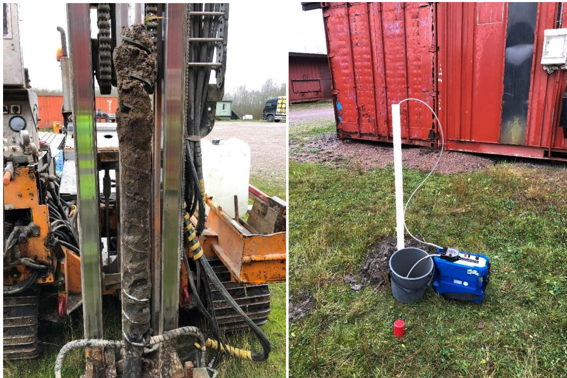
Figur 9. Till vänster: Jordprovtagning i punkt 22Ty27, 0-1 m u my. 2022-11-15. Till höger: Renspumpning av installerat grundvattenrör. 2022-11-16.
