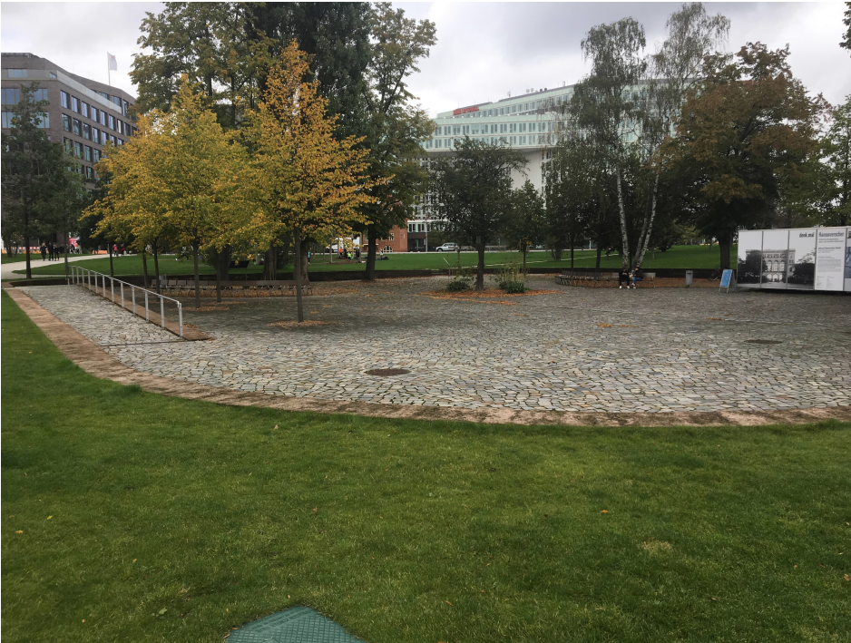
Figur 6-3 Nedsänkt parkyta som används till skyfallsfördröjning.
