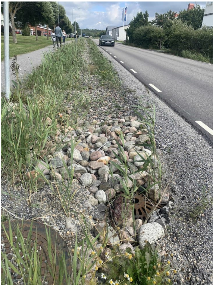
Figur 5-5 Exempel på makadamdike längst med väg.
